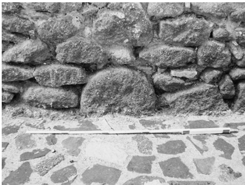
FIGURA 18. Macina reimpiegata in un muro.
